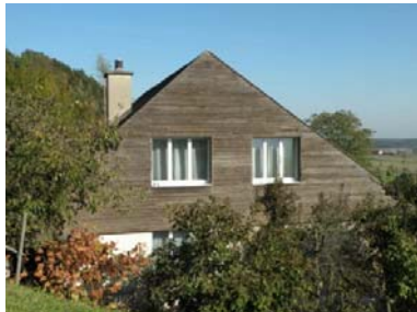
Fassaden vor Sanierung, verschiedene Ansichten der verwitterten Holzschalung
