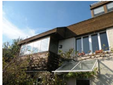
Fassaden vor Sanierung, verschiedene Ansichten der verwitterten Holzschalung
