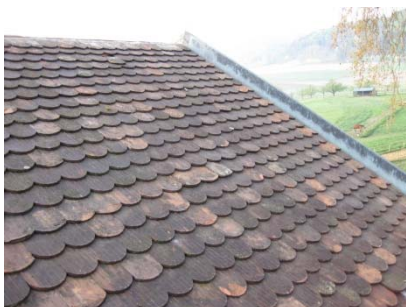
Das gereinigte Dach. Fertige Arbeit
