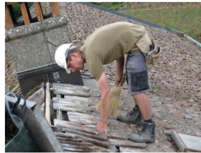
Während der Arbeit. Alle Ziegel wurden ausgedeckt, gereinigt und wieder neu verlegt
